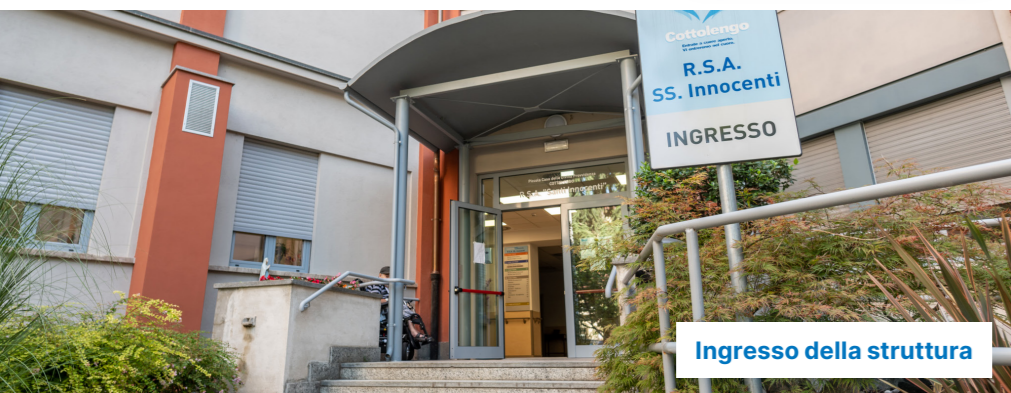
Esterno della struttura
